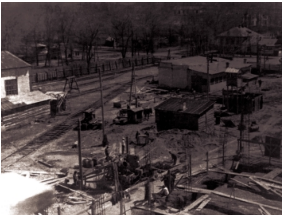
Строительство первой линии трамвая
