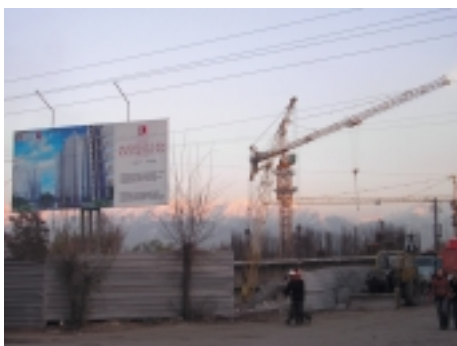
Строительная площадка «Мега-центра»
